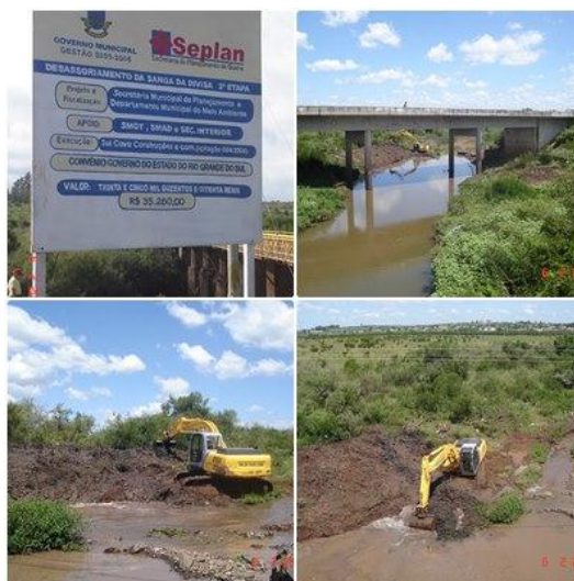
Figura 81: Segunda etapa do desassoreamento da Sanga da Divisa
