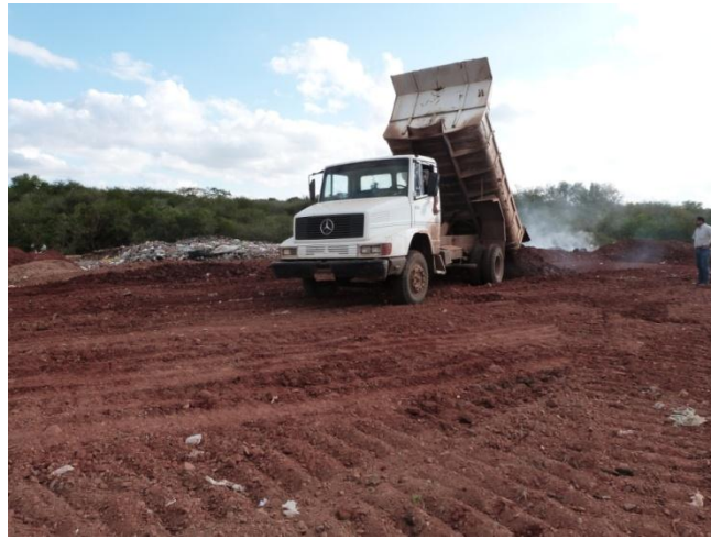
Figura 87: Recebimento dos resíduos nas células do aterro
