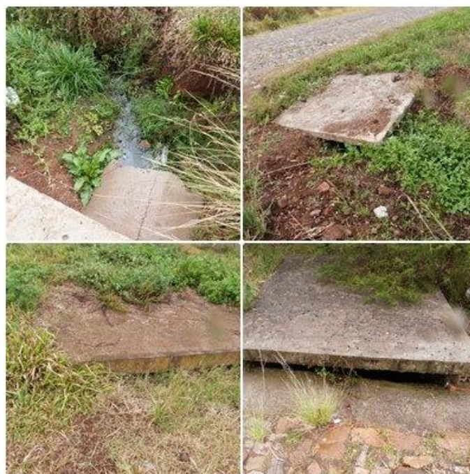
Figura 64: Estruturas de drenagem pluvial
